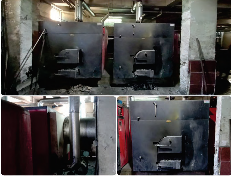
Şekil 8: Isı Merkezi – Katı Yakıtlı Kazan
