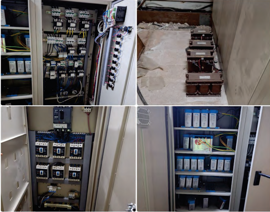
Şekil 16: Kompanzasyon Panosu Görüntüleri
