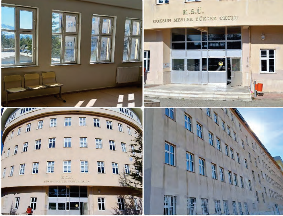
Şekil 7: Kapı - Pencere Doğrama Görünümü
