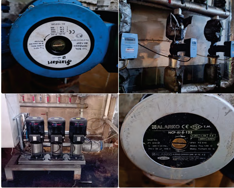
Şekil 18: Sirkülasyon Pompa Sistemi
